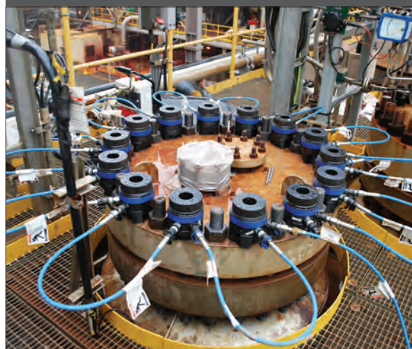
▲ Parafusos sendo tensionados na tampa de um flange do tubo com tensionadores personalizados da Enerpac.
