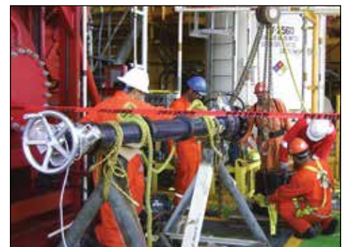
▼ Roscado en servicio de la CHT2000 en una aplicación mar afuera.
