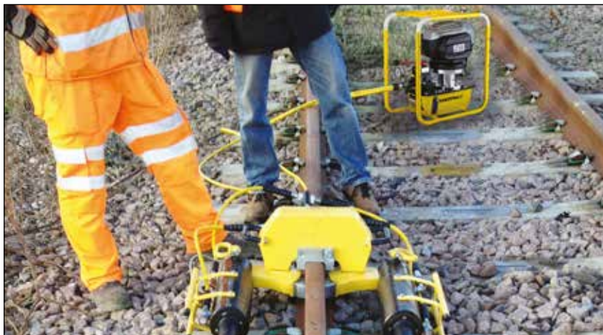
◀ Bomba especial de la serie ZC3 de Enerpac utilizada para aplicaciones de tensado de riel.
