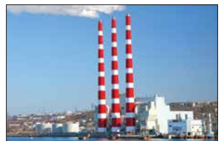
Generación de electricidad
