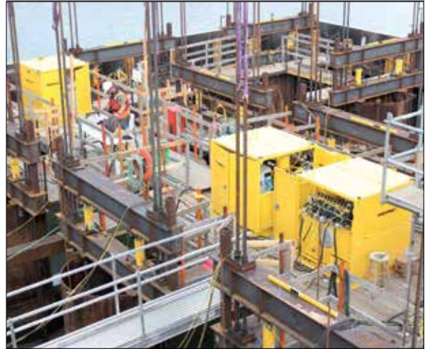
▲ Bomba hidráulica personalizada para un sistema de tendido de tablero de puente.
