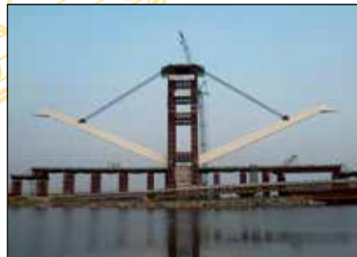
Elevación mediante gato con control preciso de alta capacidad
