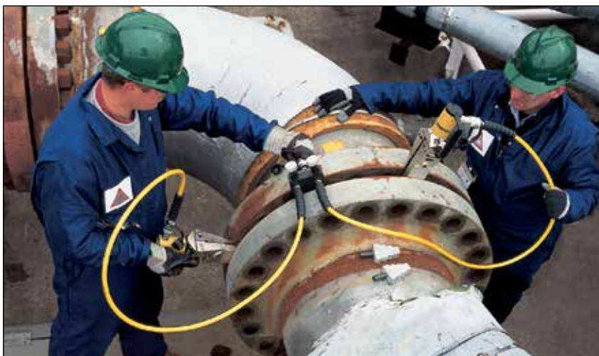
◀ Dos separadores FSH14 usados simultáneamente con bomba manual, mangueras y múltiple de control AM21 de Enerpac.
