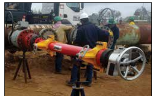
▲ Aplicación de roscado en servicio de la CHT3000 para la instalación de una tubería petroquímica.
