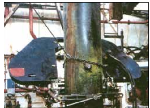
▼ Trabajo de desmantelamiento con sierra de banda.
