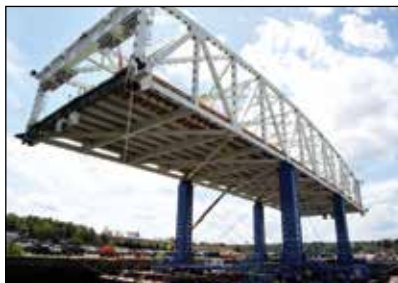
Elevación de puente en incrementos
