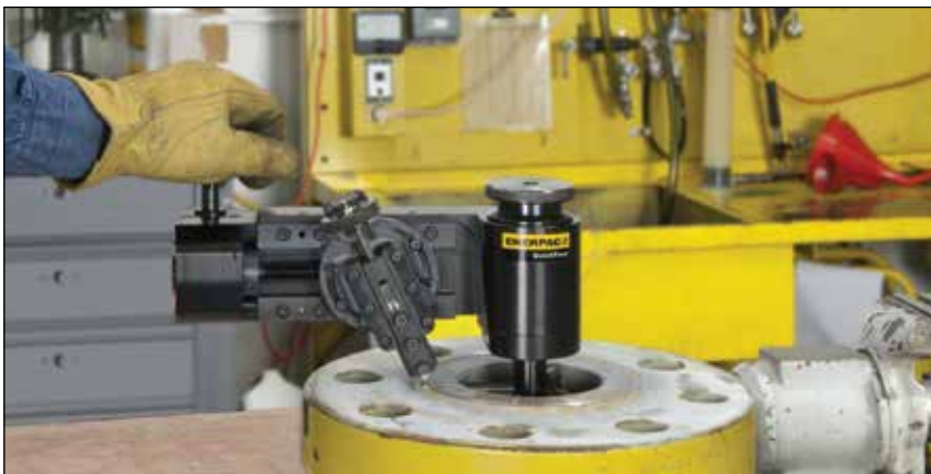
▼ La FF120 Enerpac usada para rectificar una brida de tubería.
