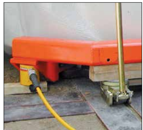
▼ Transporte de tanque para productos químicos: Para las primeras pulgadas la carga se elevó con un cilindro de baja altura de la serie RCS y luego se movió a patines de carga para su transportación.
